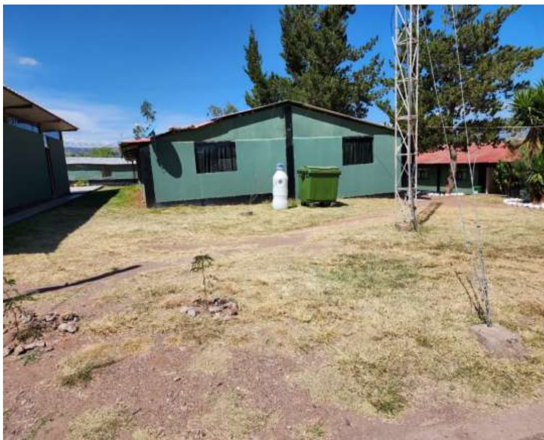
Visita a las instalaciones del cuartel e identificación de condenadores
