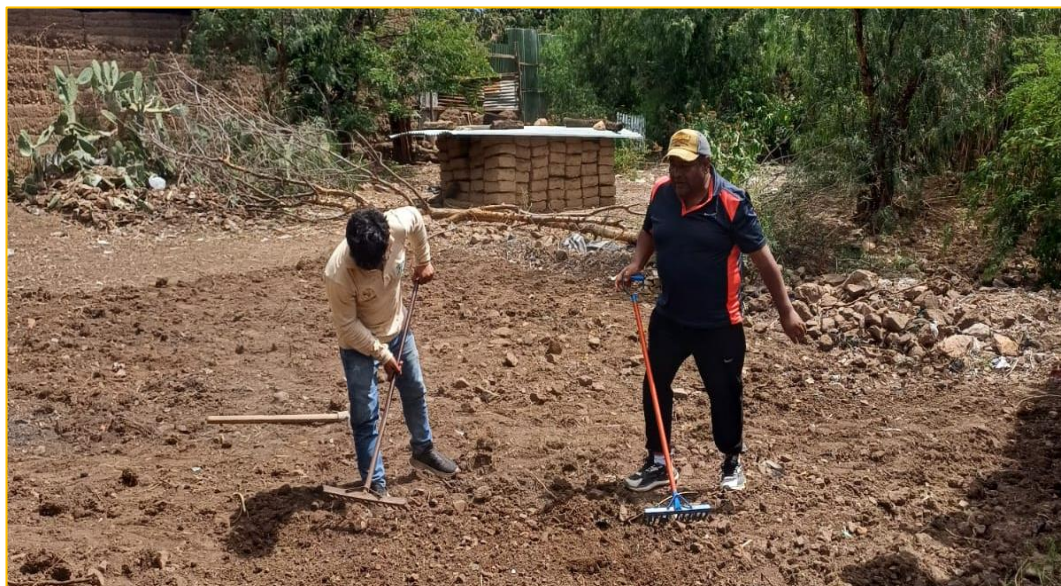
Fotografía 1: Preparación del terreno
