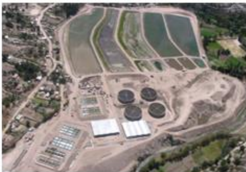
VISTA PANORAMICA PTAR TOTORA
