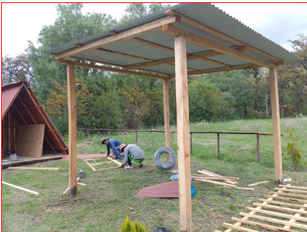
construcción del glamping y su espacio de expendio
