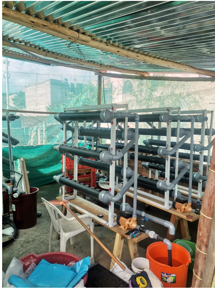
Figura C.6. Montaje de tubos, canales y conexiones hidráulicas del sistema NFT.
